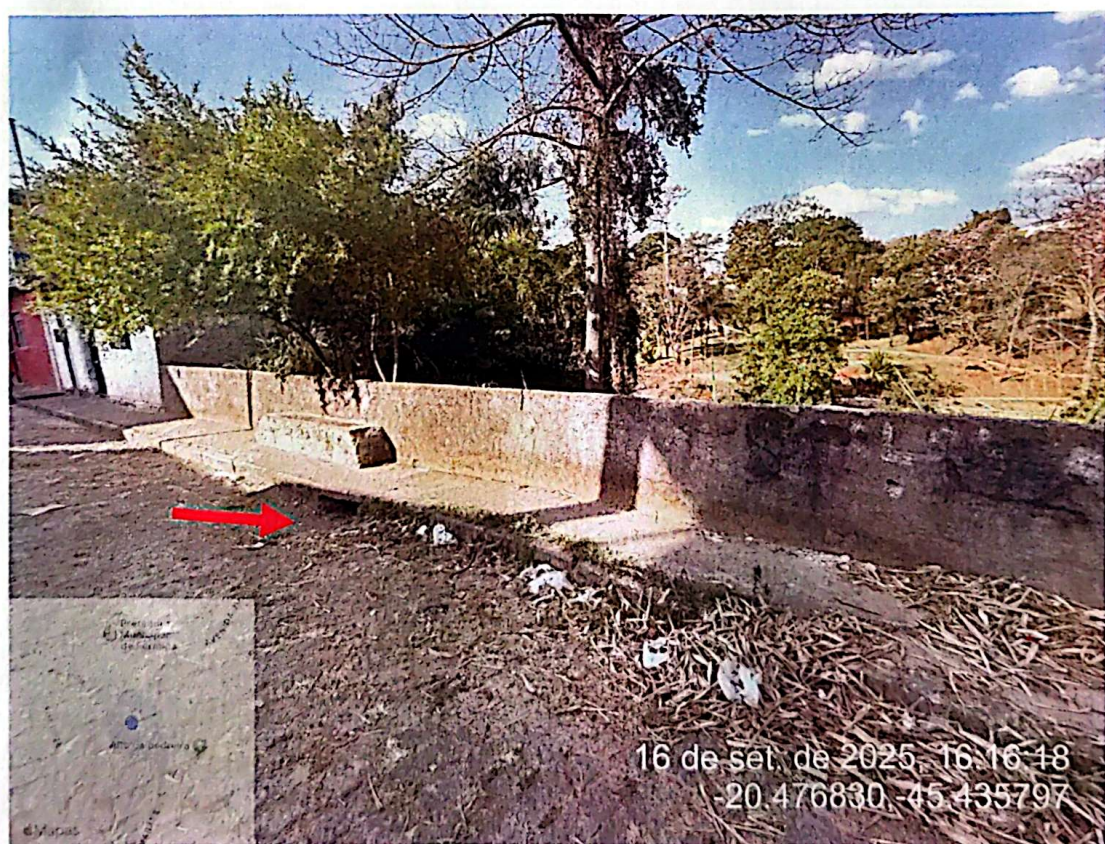
FOTO 04 - Ponto de captação das águas pluviais da Rua da Charqueada.
