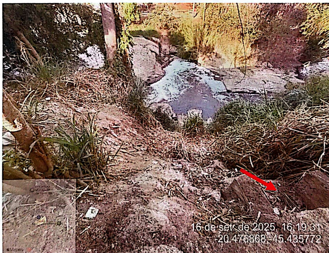
FOTO 06 – Saída da boca de lobo na crista do talude da Rua da Charqueada.
