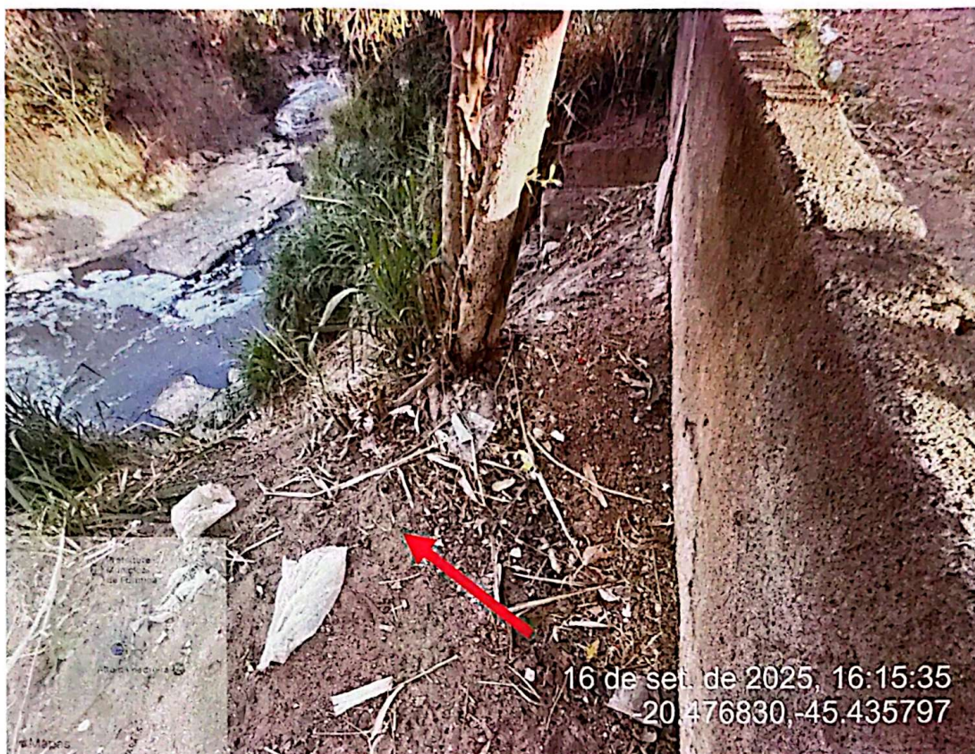
FOTO 05 – Presença de entulho de construção civil misturado com resíduos recicláveis no talude da Rua da Charqueada.
