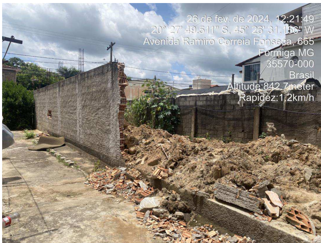
Imagem 7: Vista do corredor de entrada do imóvel
