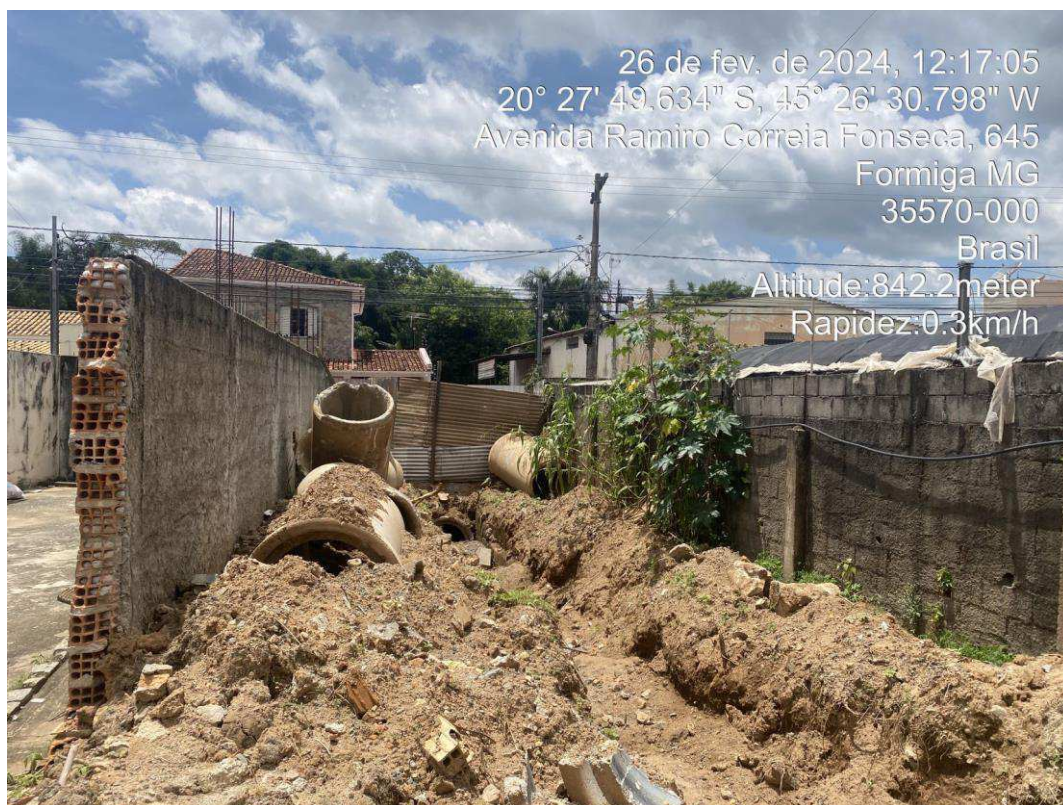
Imagem 6: Vista do corredor de entrada do imóvel
