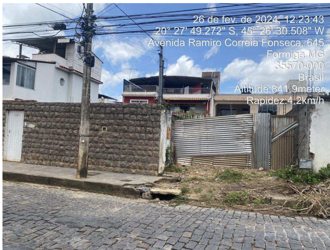
Imagem 5: Segunda vista frontal do imóvel
