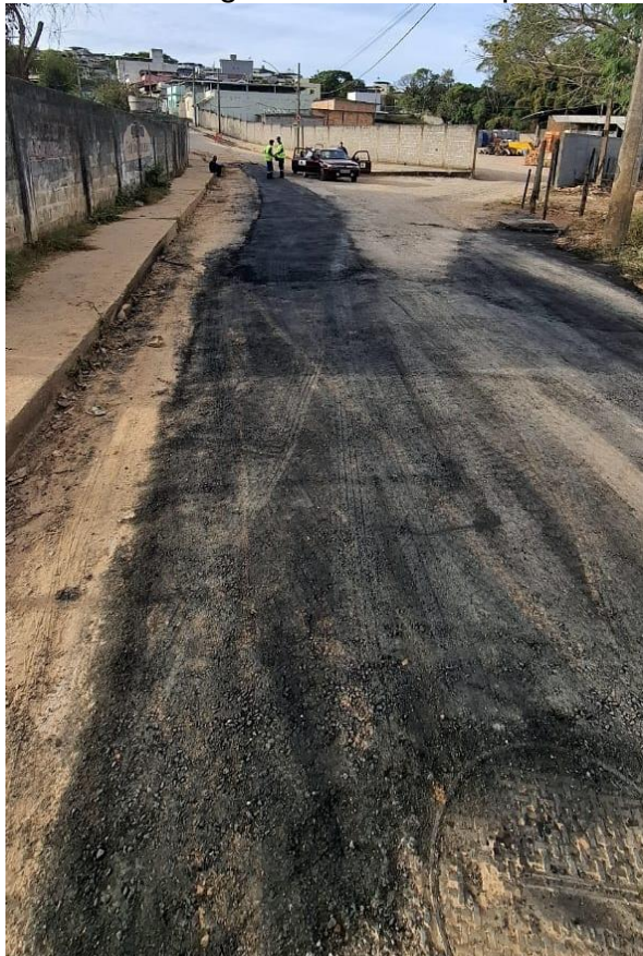
Imagens 1 e 2 – Recapeamento asfáltico Rua Furtado Menezes
