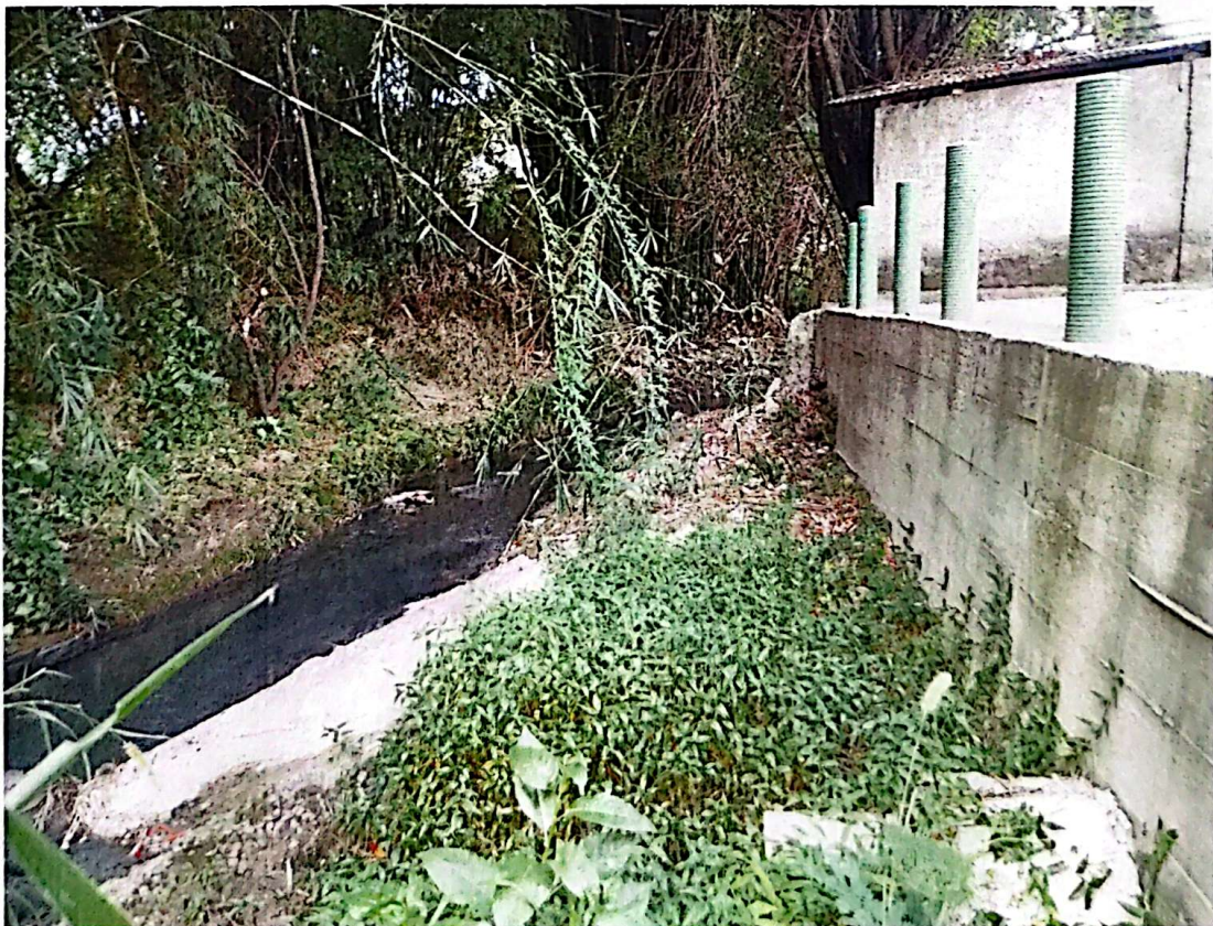
FOTO 02 – Muro de contenção executado pela Secretaria Municipal de Obras e Trânsito para estabilidade da Rua Divino Carlos.
