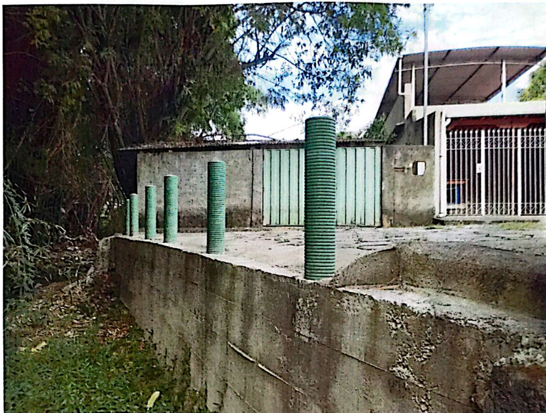
FOTO 03 – Detalhe do muro de contenção com vista de outro ângulo de visão e aos fundos a garagem da residência nº50 (portão verde).
