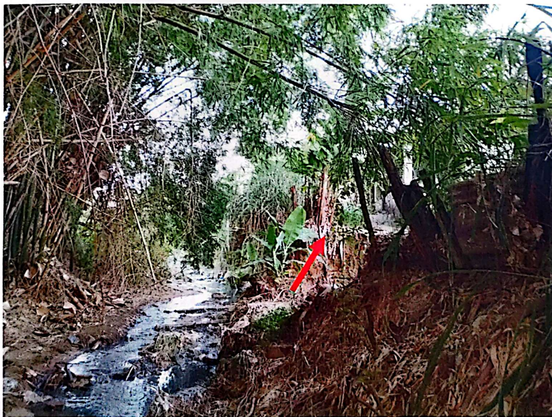
FOTO 04 - Córrego do matadouro com detalhe para ausência de uma contenção do terreno da residência nº 50.
