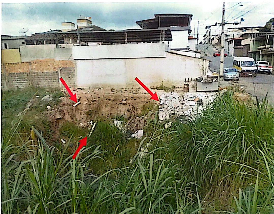
FOTO 02 – Detalhe do entulho de restos de construção civil e tubulação de pvc exposta no talude que confronta com o córrego.
