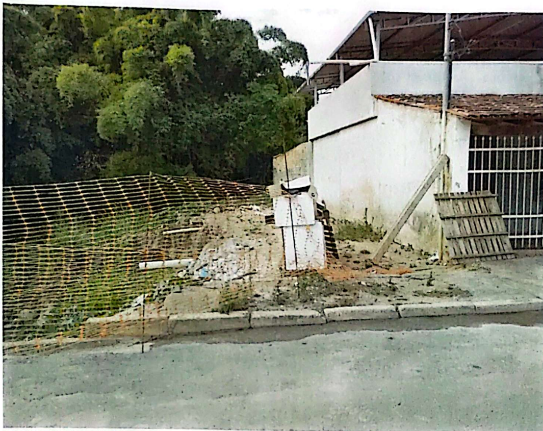
FOTO 03 – Isolamento da Rua Joaquim Ferreira de Resende com a erosão com tela de tapume.
